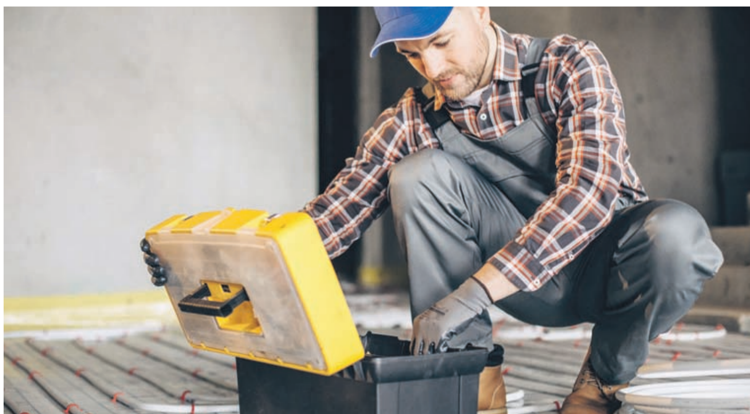
Übliche Fußbodenheizungen benötigen mehr Antriebsenergie für eine Wärmepumpe.
